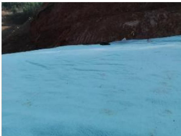
项目施工期（填埋场底部防渗）
