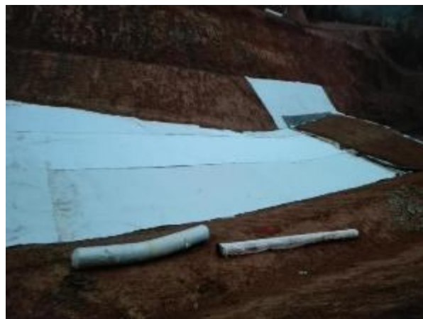
项目施工期（填埋场底部防渗）
