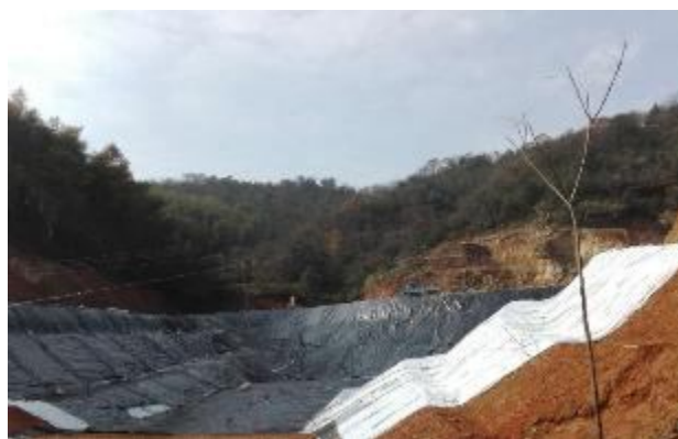
项目施工期（填埋场边坡防渗）
