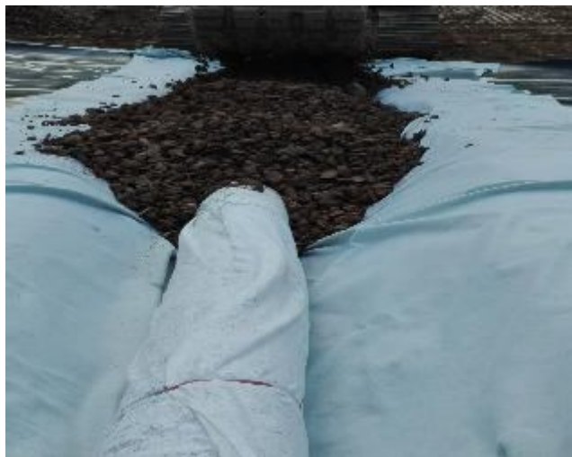
项目施工期（填埋场渗滤液导排）
