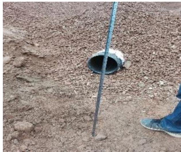
项目施工期（填埋场地下水导排，砂石导排层）
