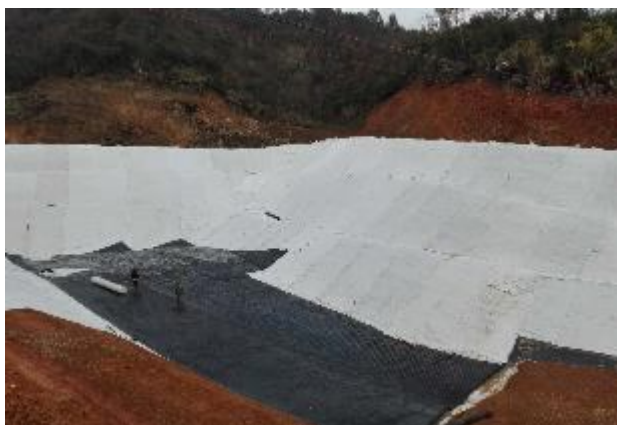
项目施工期（填埋场边坡防渗）
