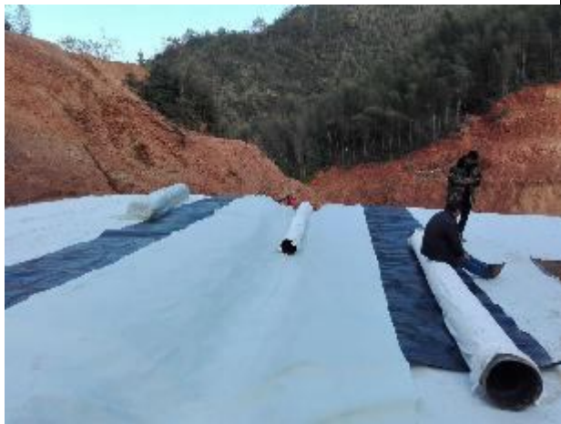
项目施工期（填埋场渗滤液导排）
