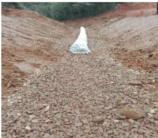
项目施工期（填埋场地下水导排，砂石导排层）
