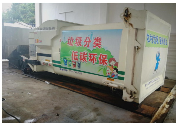
图 5-3 垃圾转运站压缩设备
