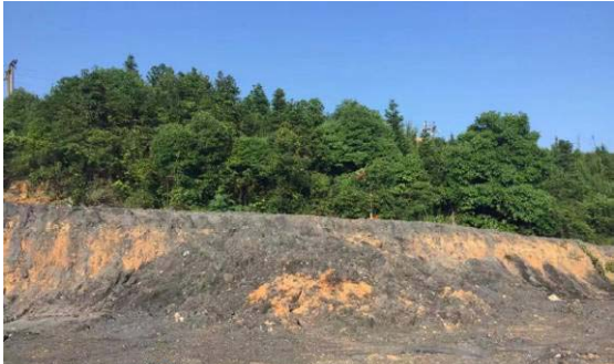
大仑山隧道出口
