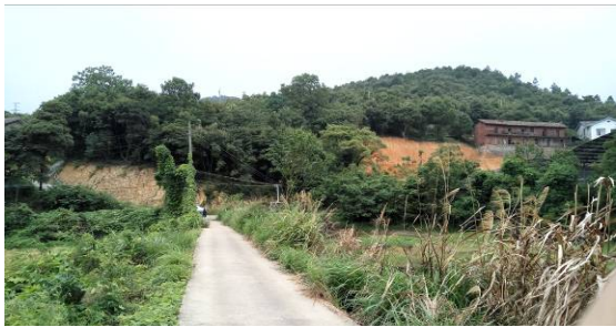
仙岳山隧道进口
