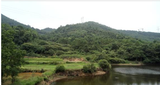
仙岳山隧道进口
