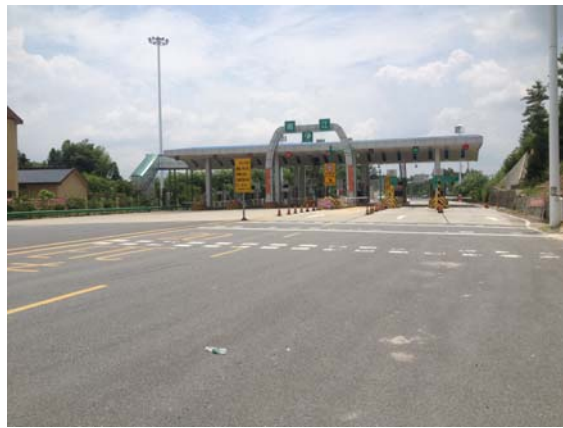
图 4-1 上跨连接高速出口且上跨 G106 道路点
