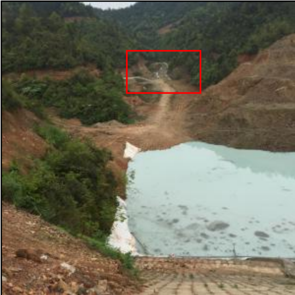
石坪尾矿库排水斜槽
