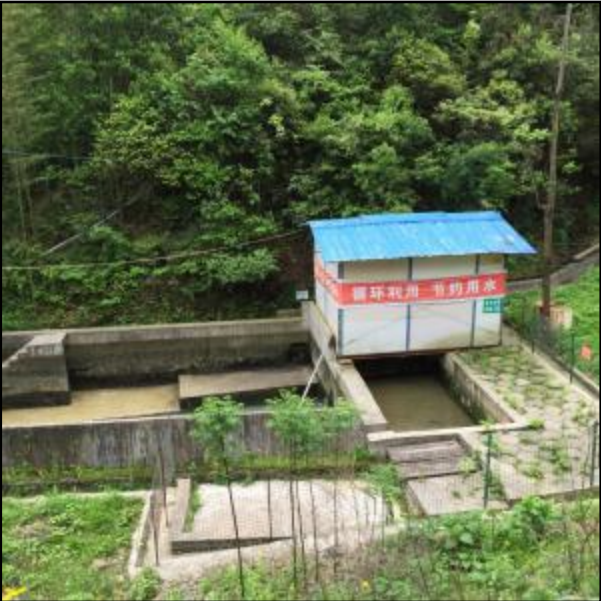
正坡垅尾矿库污水处理站
