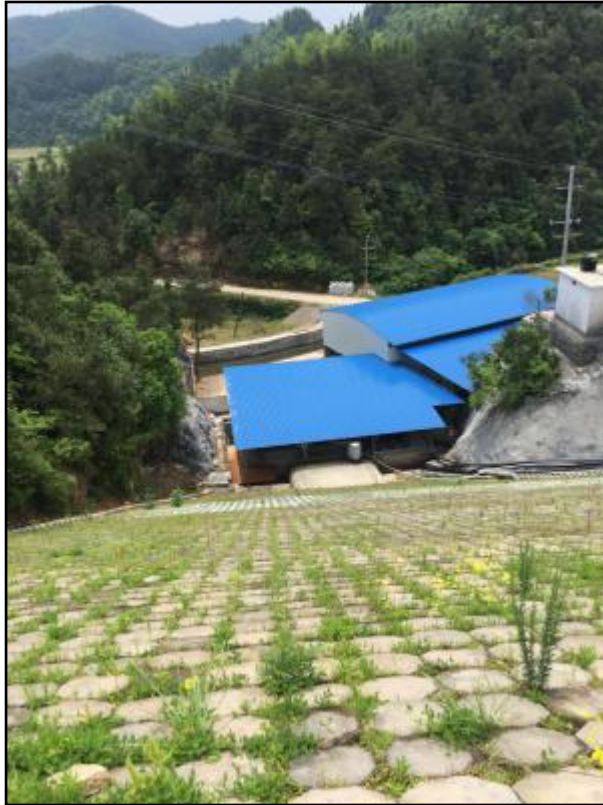
石坪尾矿库污水处理站
