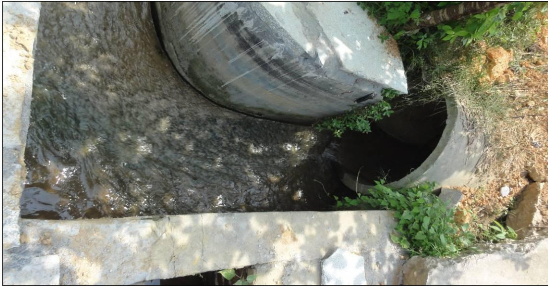
图 1 沿平伍公路敷设的污水干管出水口
