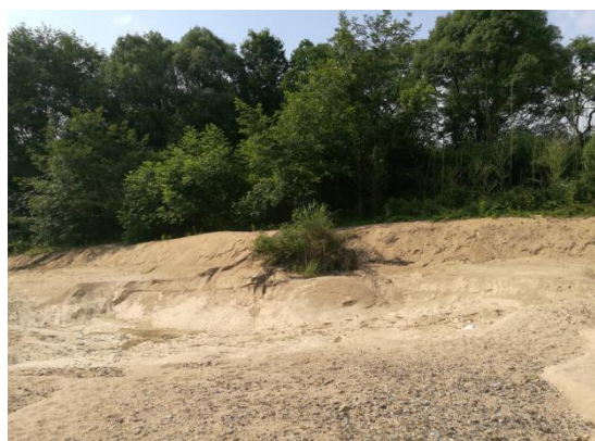
图 1.4-5 土质边坡现状
