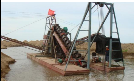
图 1.4-2 水上挖沙船施工
