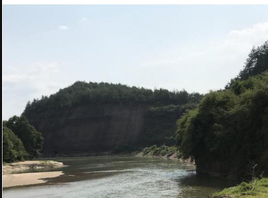
图 1.4-4 岩质边坡现状
