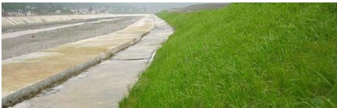
图 1.4-7 三维土工网植草护坡意向图
