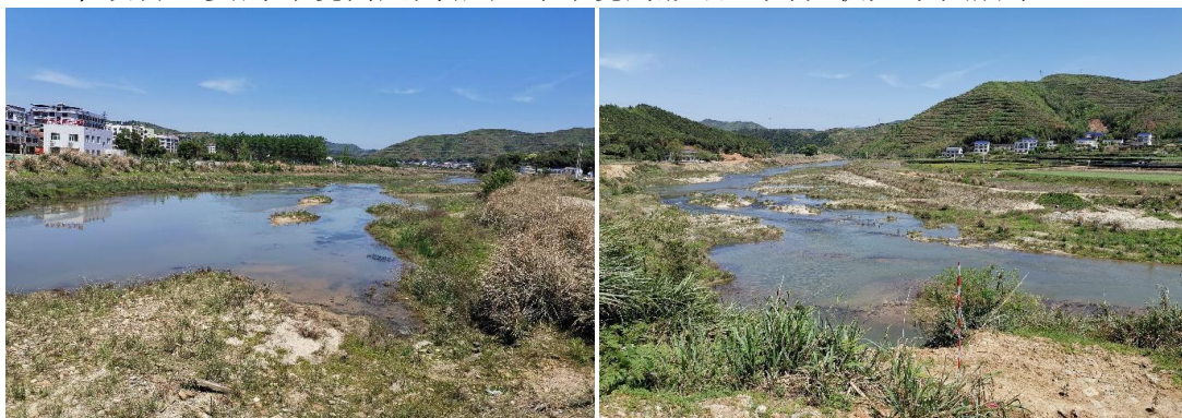
图 1-1 钟洞河淤积现状
