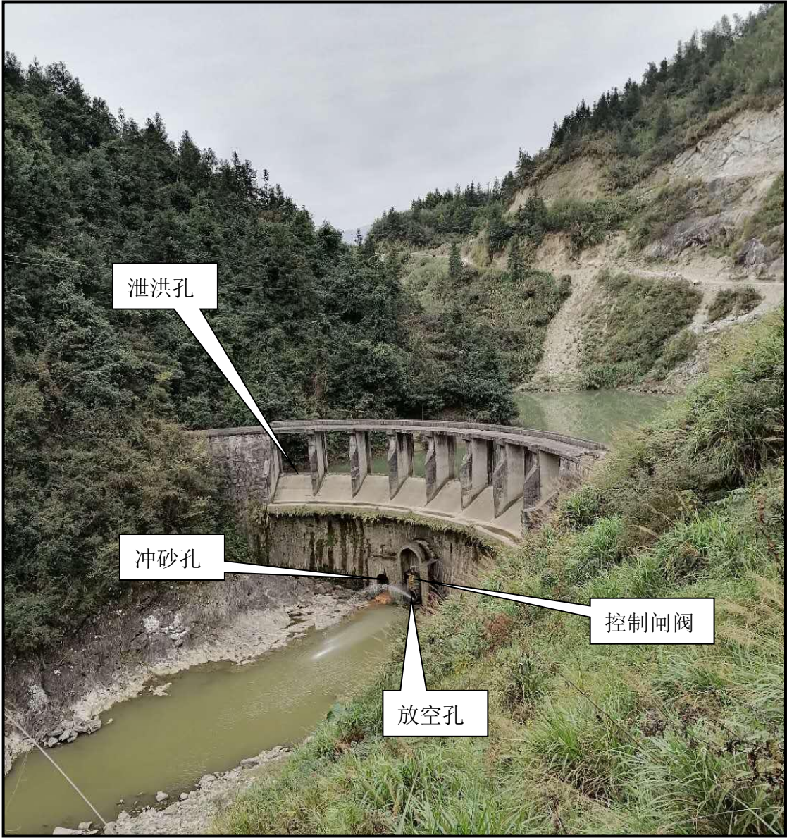
图 7.7-1 生态泄流设施示意
