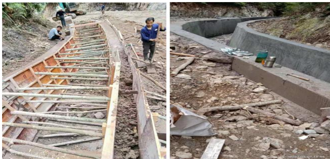
3.6 黄沙村住庙组新建截洪沟 407.5m、排水沟 9.5m
