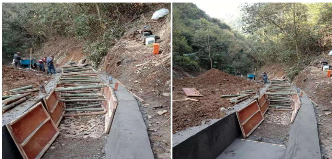
6.4 龙洞村下簸箕新建截洪沟 92.4m、排水沟 7.8m
