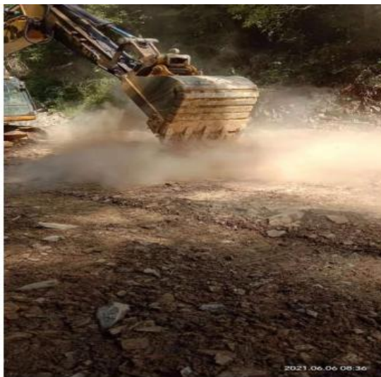
1.2 黄沙村老屋组现场药剂拌和 5700m 3
