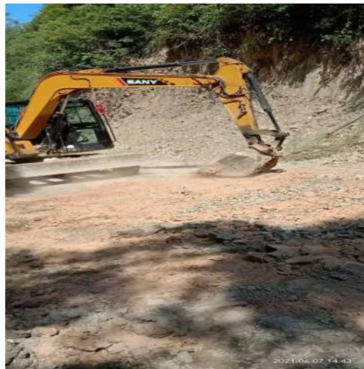
3.2 黄沙村住庙组现场药剂拌和 1067.5m 3
