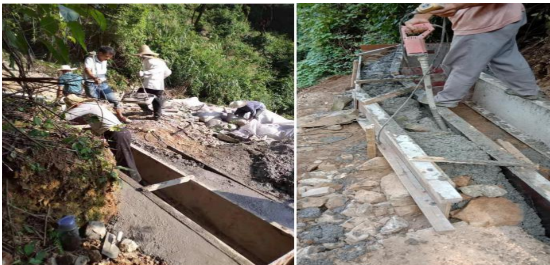
5.5 龙洞村细小王洞新建截洪沟 113m、排水沟 14.8m
