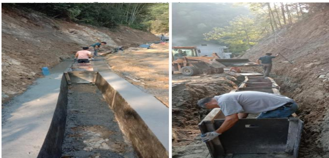
2.6 黄沙村株树组新建截洪沟 326m、排水沟 190m
