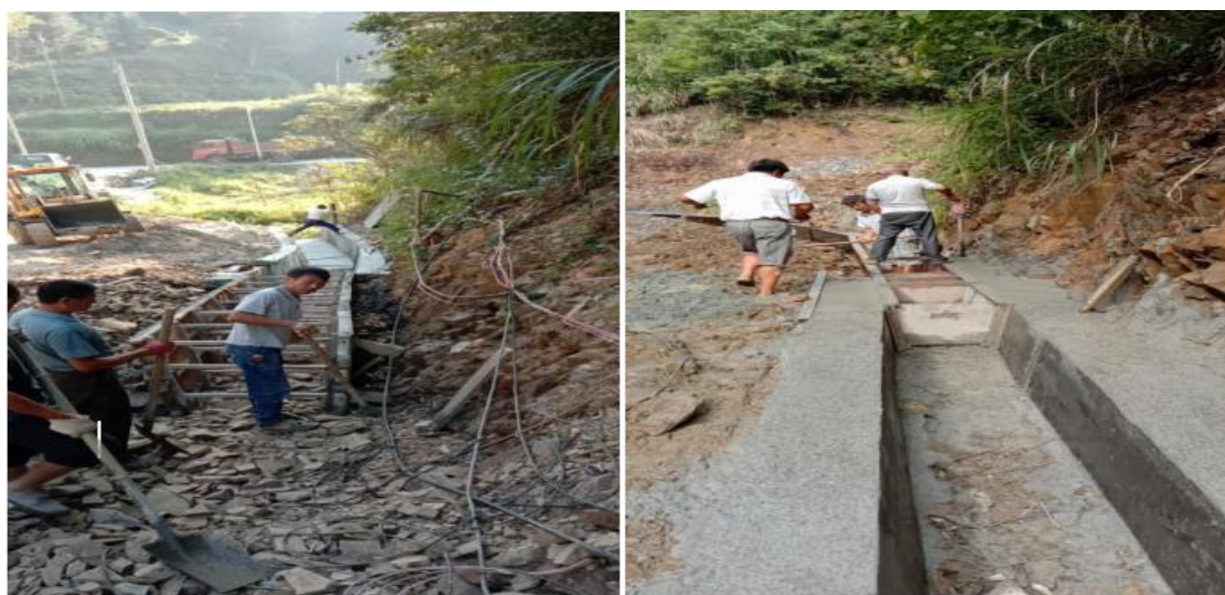
1.5 黄沙村老屋组新建截洪沟 379.6m、排水沟 260.5m
