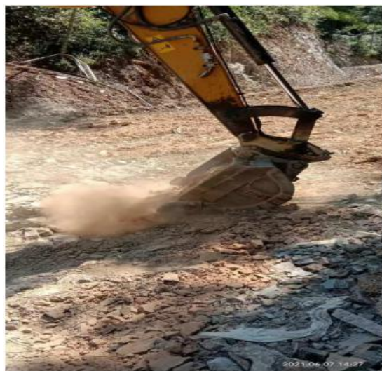
3.2 黄沙村住庙组现场药剂拌和 1067.5m 3
