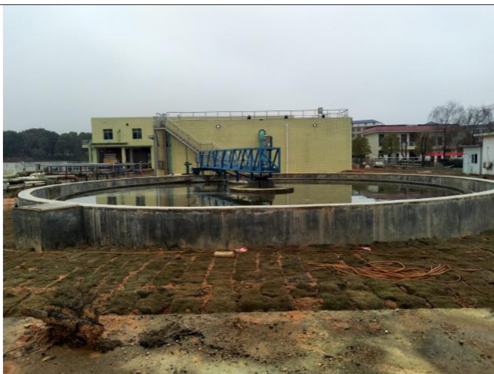
二期工程沉淀池
