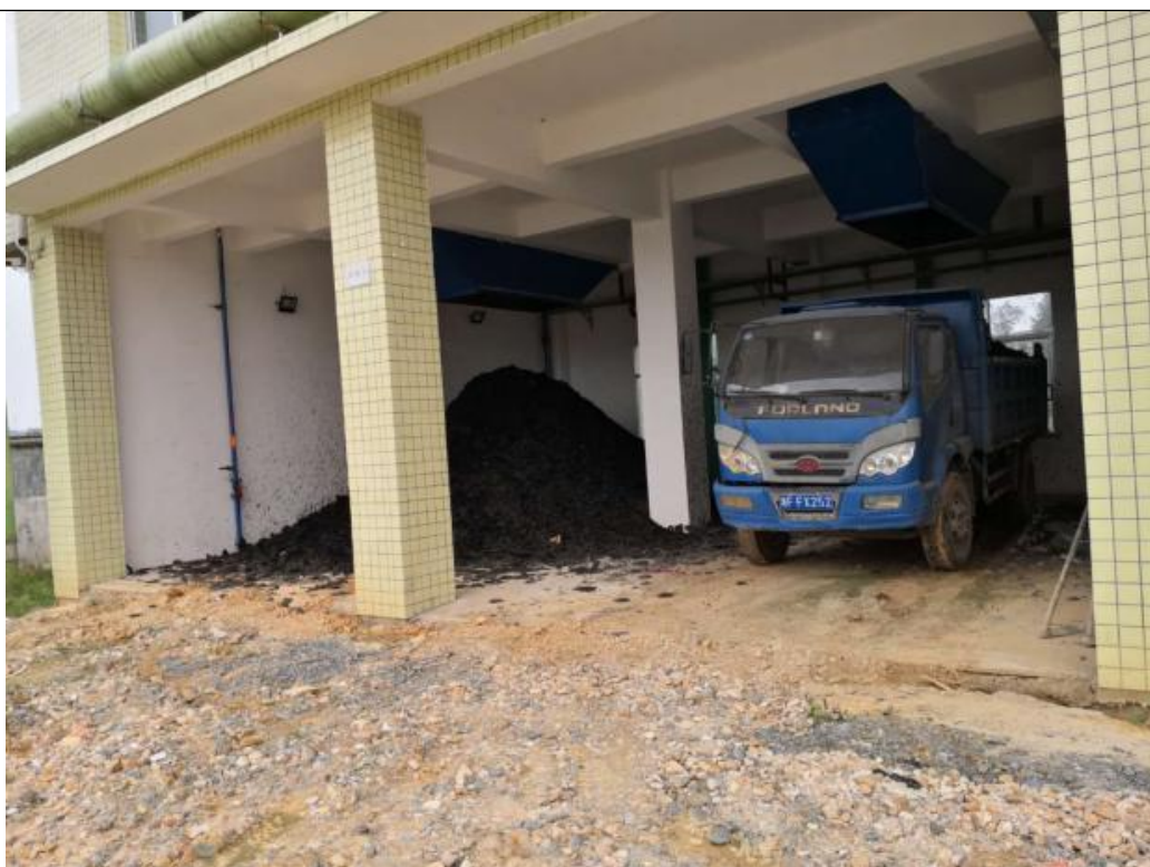
一期工程污泥脱水间
