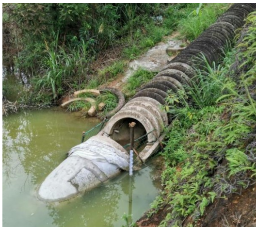
图 2-8 排水斜槽进口
