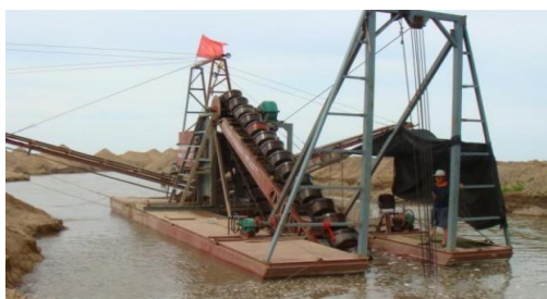
水上清障船施工
