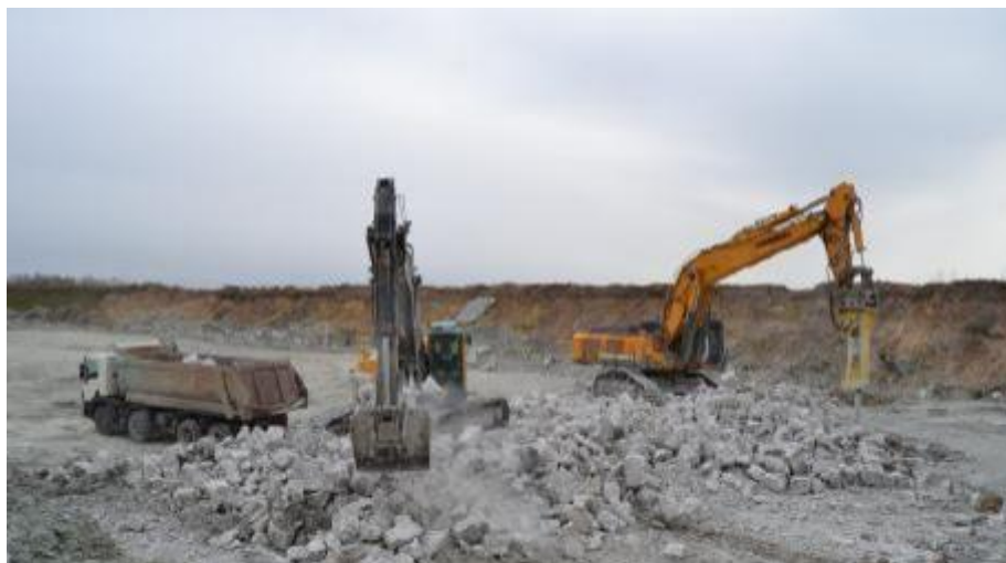
图 3.4-1 液压挖掘机+破碎锤破岩工艺图
